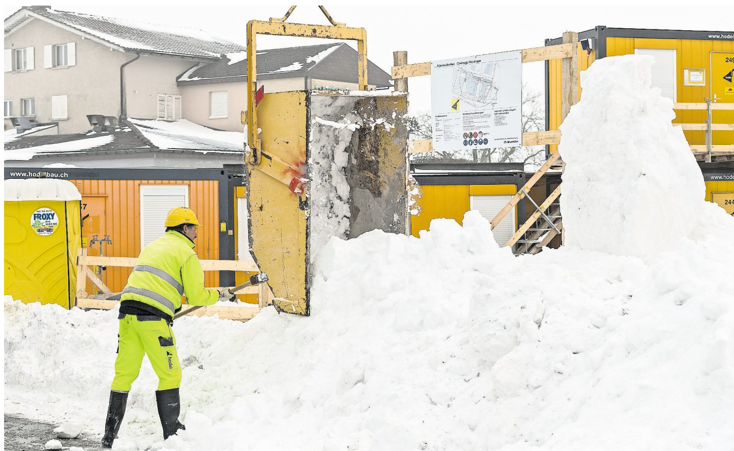
Auf dieser Baustelle im Gebiet Kreuzegg wird nicht gebaut, sondern Schnee weggeräumt. Bild: Christian H. Hildebrand (Menzingen, 20. Januar 2017).
