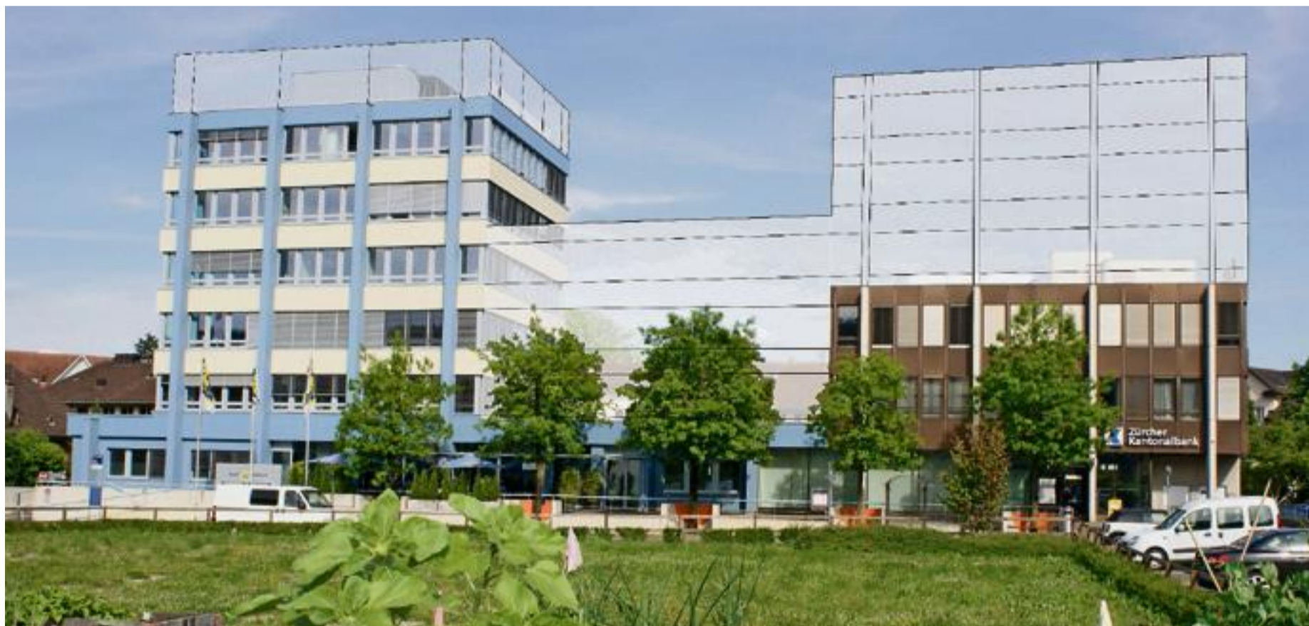
Gemäss Gestaltungsplan sollen das Mittelgebäude und das Gebäude rechts um je drei Stockwerke erhöht werden. Die Aufstockung beim Gebäude links ist optional.
